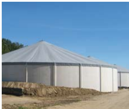
Schweinemastanlage, Behälter mit Zeltdach
