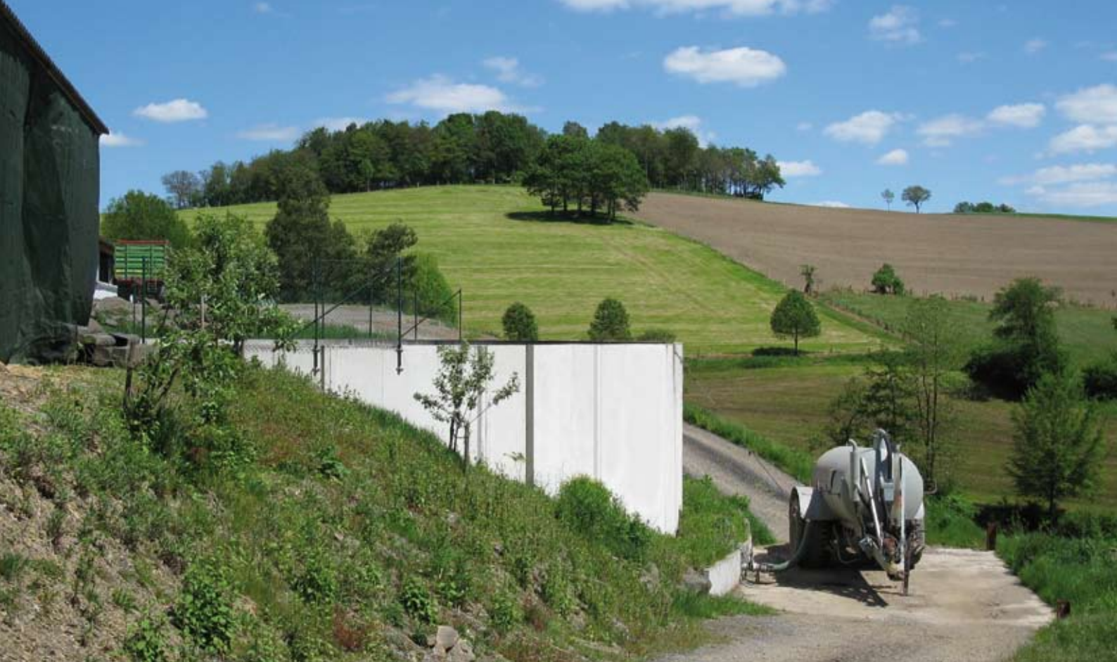
Behälter in Hanglage
